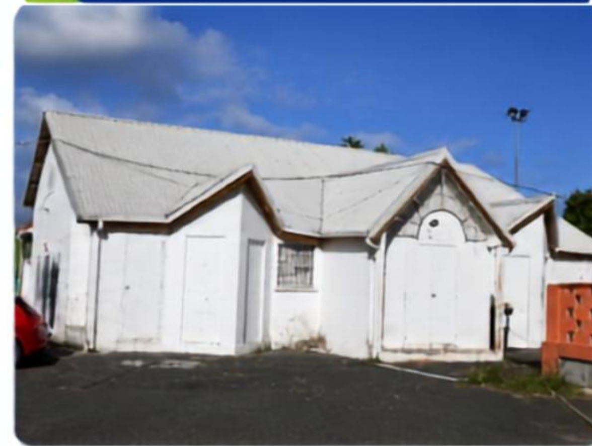
Maison de quartier de La Boucan
